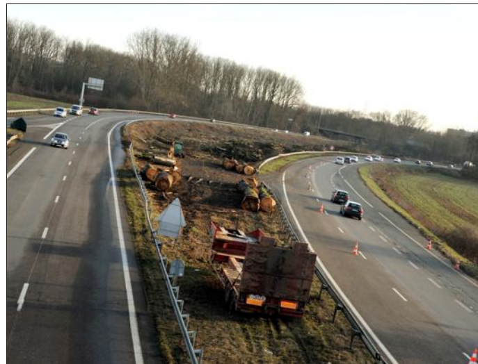
Le chantier de bûcheronnage se termine sur le terre-plein central à hauteur d'Uckange. Photo Armand FLOHR
